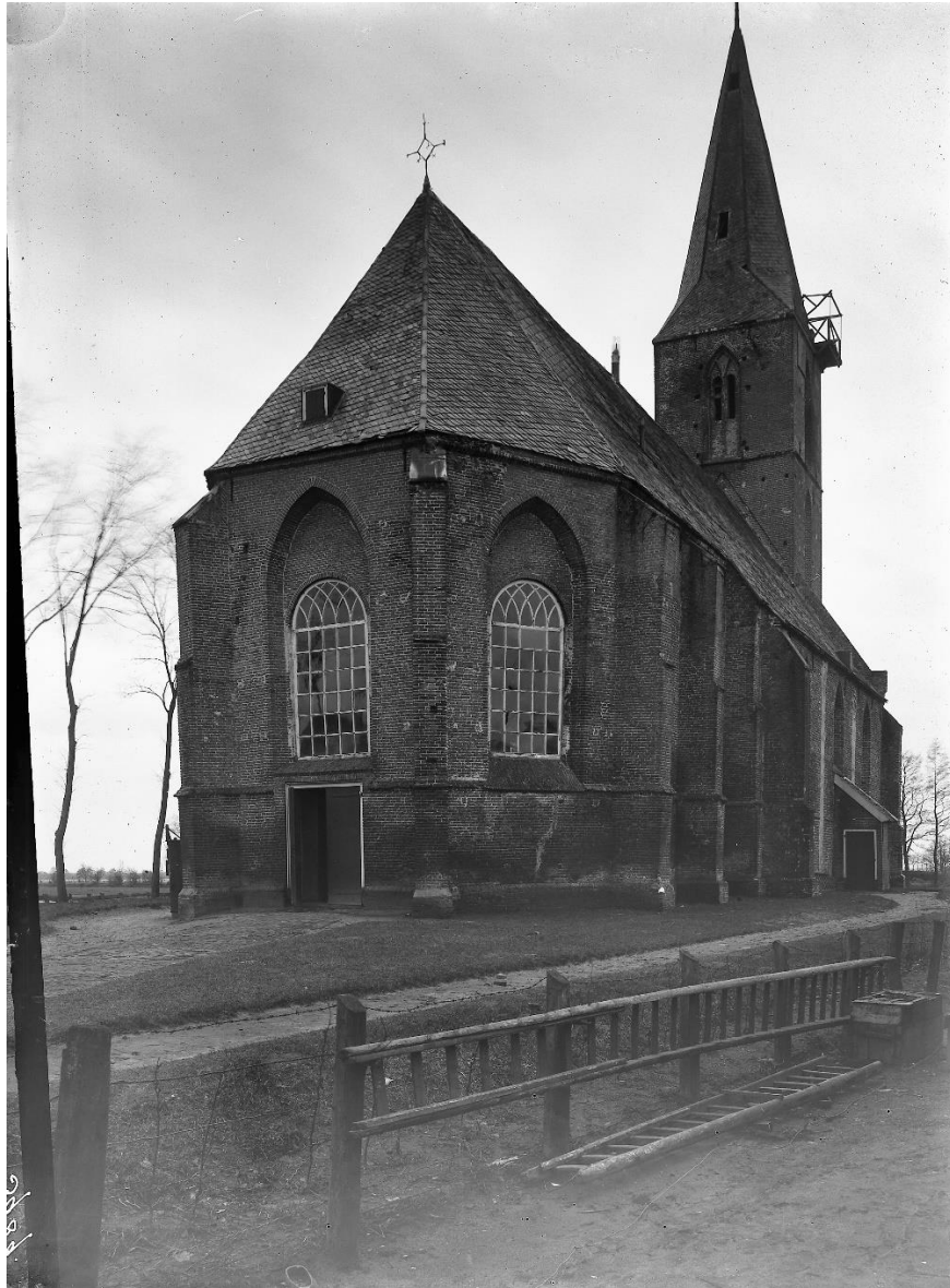
12. Oostzijde in 1920: de weinig subtiële rechthoekige koorentree is bij de restauratie dichtgezet (foto RCE).
