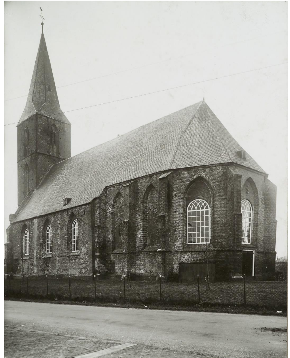
13. Zuidoostzijde: van de twee blinde vensters in het koor is er tegenwoordig nog één over (foto RCE).
