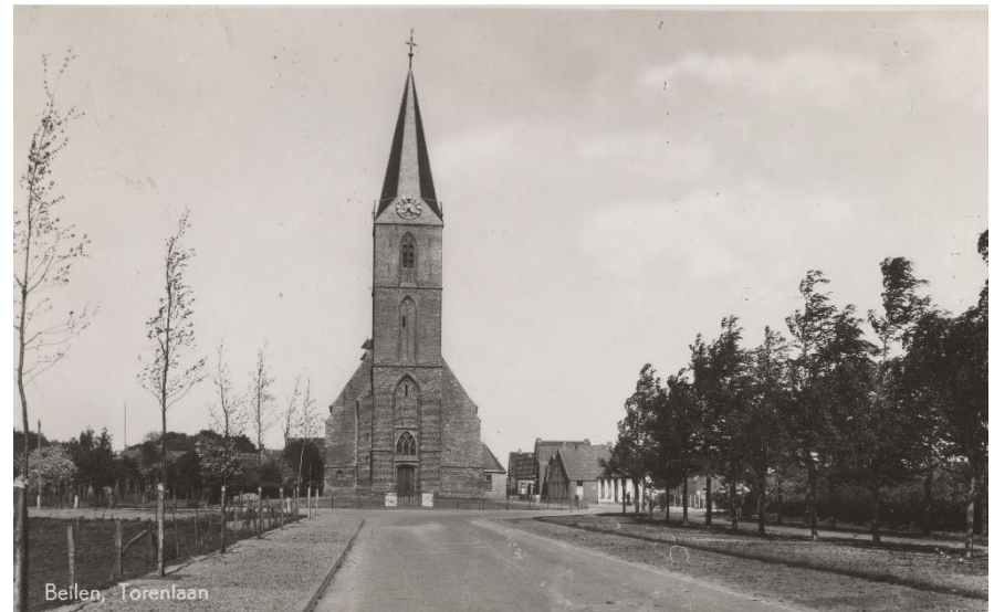
90. De nieuwe Torenlaan (links), naast de oude. Jaren vijftig (foto Drents Archief).
