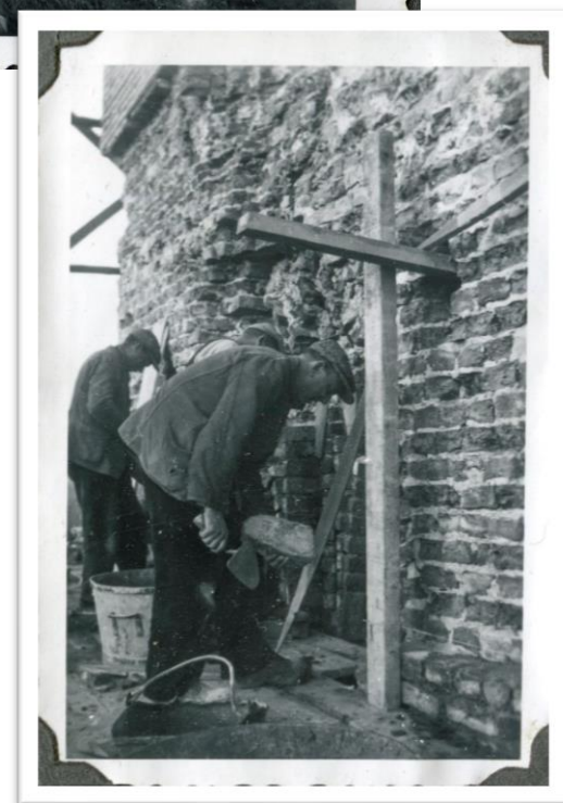
17 - 18. Kiekjes uit een fotoalbum van de restauratie. Boven: de zuidgevel in de steigers. Het dak is al beplankt. Onder: de buitenschil van de toren (bovenkant tweede geleding) wordt opnieuw opgemetseld (afb. Bé van der Veen).
