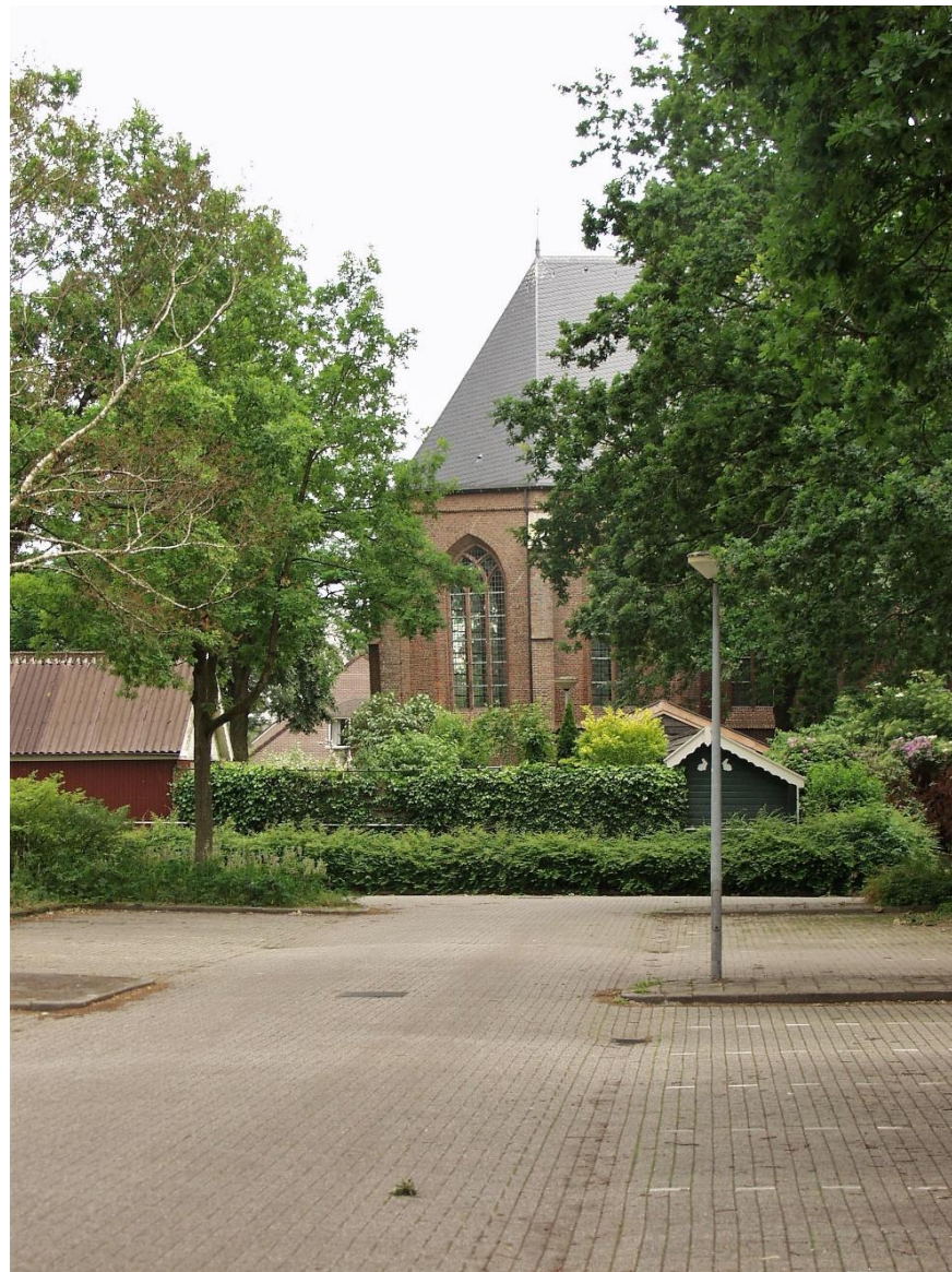
67. zicht op het koor vanaf de parkeerplaats.
