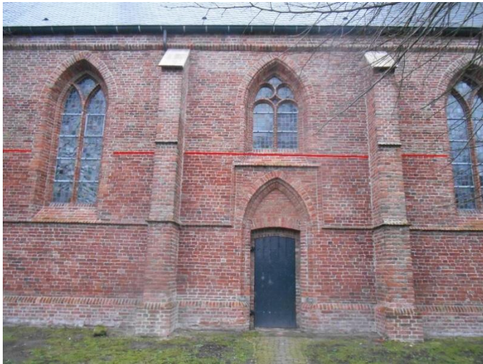
7. Noordzijde schip: grens tussen bouwfases.
