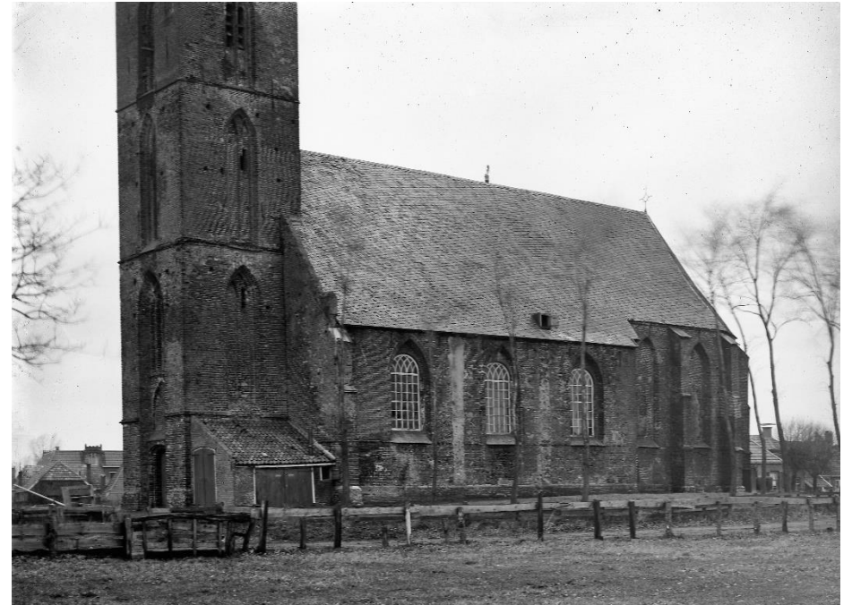
15. Zuidwestzijde in 1920: het hok tegen de toren was in 1937 al verdwenen. Op de plaats van de huidige 'gotische' entreepartij met bovenlicht zien we hier een 19 de -eeuws raamvenster (foto RCE).
